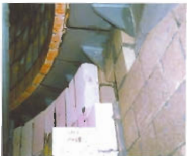
Консольный уровень камеры старания с многослойной футеровкой перед монтажом [вверху] и во время монтажа [внизу], металлическая обшивка обеспечена жаростойкой антикоррозионной защитой.
