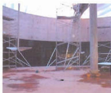
Емкость для складирования с дополнительной футеровочной системой из термопласта Балтед Лининг, установленной при помощи винтов.
