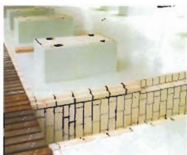
Поверхность пола с нанесенным покрытием и цоколь с футерованными желобами.
