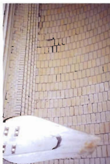
Гуммирование и трехслойная футеровка в башне Вентури.
