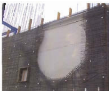
«Стайлер» использует систему Беккалост также как футеровку для промышленных бетонных емкостей на установках для обессеривания дымовых газов.
