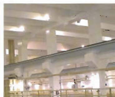
Защита цехового оборудования агрессивных ларов с помощью покрытия, нанесенного методом разбрызгивания.
