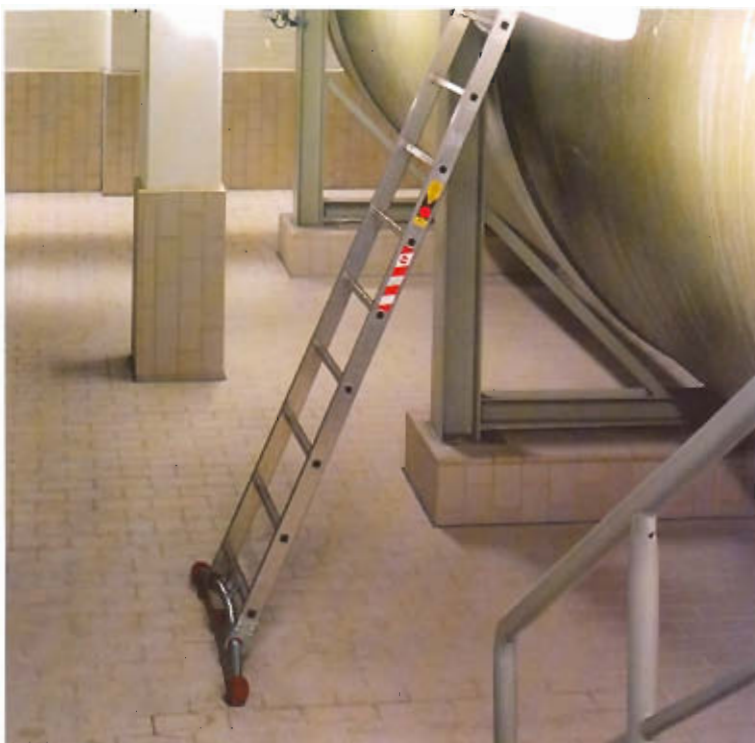
Уплотнение улавливающей ванны на складе кислот с дополнительной лакировкой.
