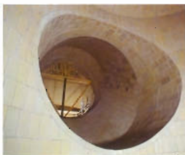
Входной патрубок газа в абсорбер при производстве серной кислоты.
