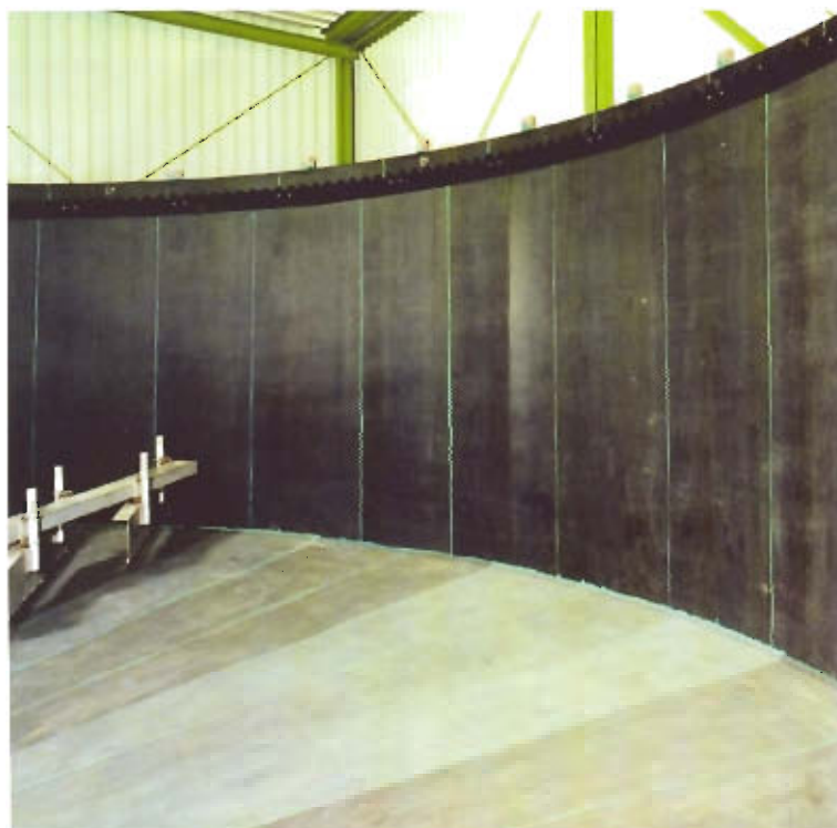
Гуммированный корпус мешалки, используемой в химическом производстве. Также здесь было выполнено гуммирование кальцевого ограничителя и всех несущих конструкций.
