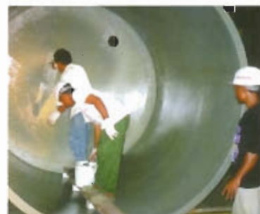
Нанесение полиуретанового покрытия на корпус реактора с титановым усилением на днище корпуса.
