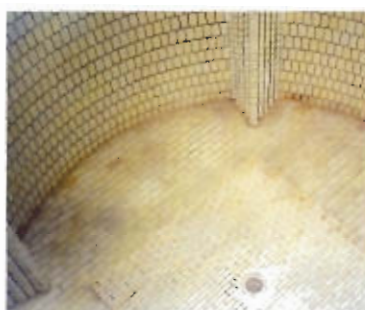
Футерованный корпус реактора с дополнительной защитой от износа с волновым дефлектором.
