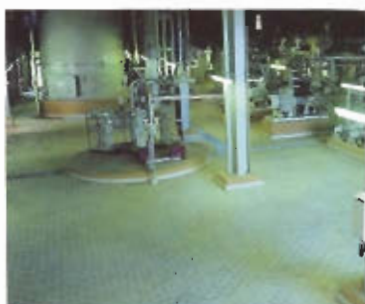
Обширное уплотнение и лакирование на установке для обесщелачивания дымовых газов.
