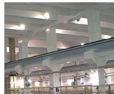
Auch Hallenkonstruktionen werden mit einer spritzfähigen Beschichtung gegen die aggressiven Dämpfe geschützt.
