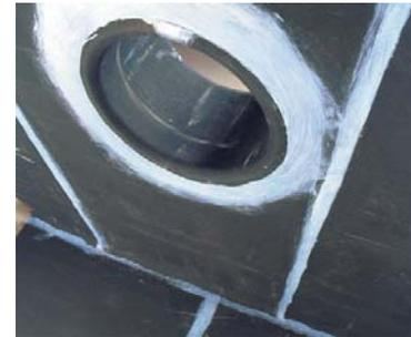
Gummierungsdetail mit Stützen, die zusätzliche Ausmauerung mit Kohlenstoffsteinen folgt.
