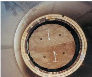
Gummierung und dreilagige Ausmauerung in einem Venturi.
