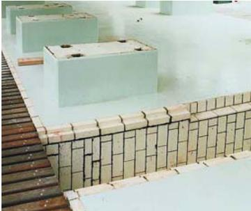
Beschichtete Bodenflächen und Sockel mit ausgemauertem Rinnenkonstruktion.
