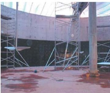
Lagerbehälter mit nachträglich angeschraubter Thermoplastauskleidung System Bolted Lining™.
