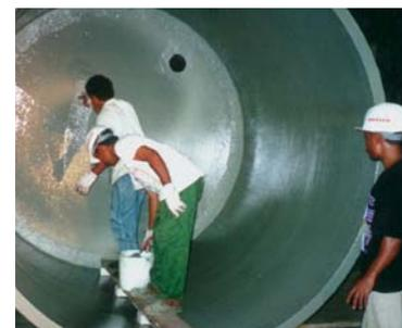
Polyurethanbeschichtung eines Reaktorbehälters mit Gewebeerstärkung am Behälterboden.
