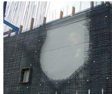
Steuler setzt Bekaplast™ auch als Betonwäscher-Auskleidung in Rauchgasentschwefelungsanlagen ein.
