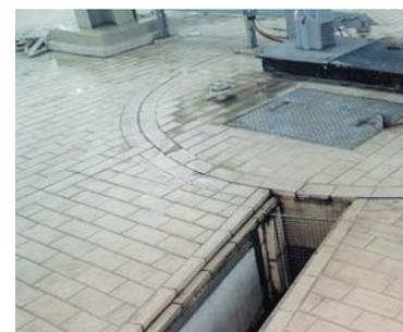
Mechanisch im Fundament verankerte Thermoplastrinnen mit speziellen Detaillösungen zur Anbindung an plattierten Industrieböden werden im Werk vorgefertigt.
