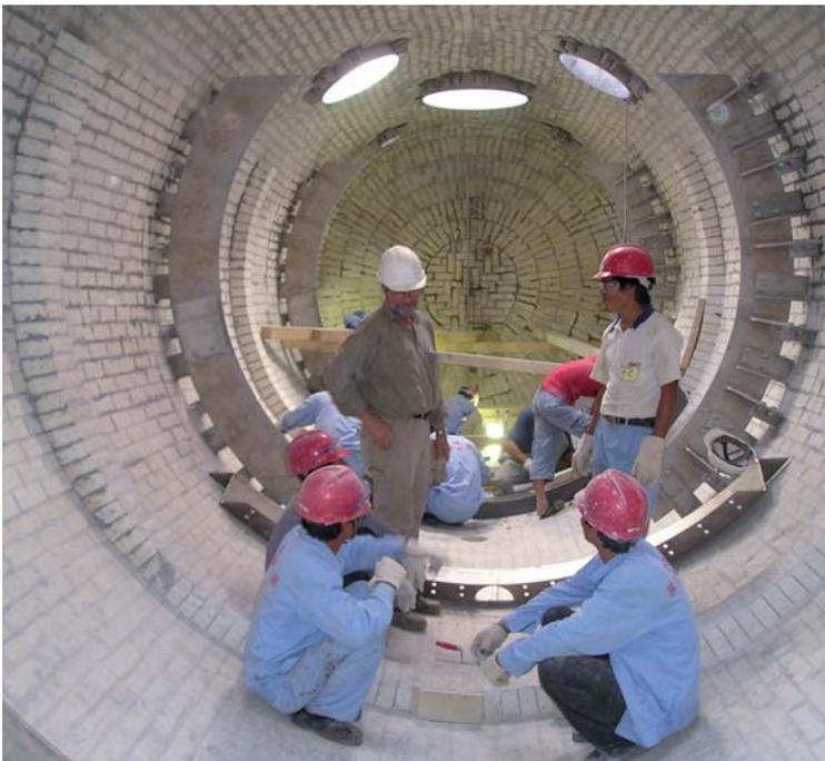
*Montage von Wellenbrechern aus Metall in einem Autoklaven*
