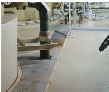
*Nach Wasserhaushaltsschutzgesetz beschichteter Produktionsbereich. Steuler liefert auch Rohrleitungen aus Duro- und Thermoplasten.*
