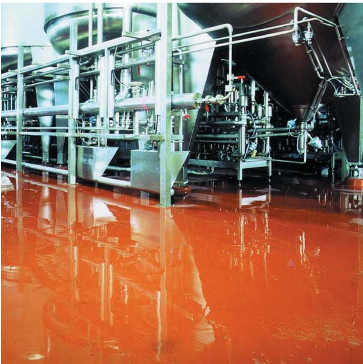
Selbstverlaufender Industriefußboden in der Lebensmittelindustrie: poren dicht, leicht zu reinigen, sicher auch gegen aggressive Reinigungsmittel, mechanisch hoch belastbar.
