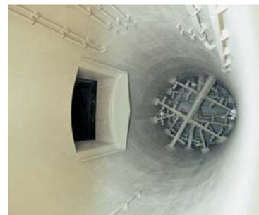
Betonwäscherkonstruktion einer Rauchgasentschwefelungsanlage mit mechanisch verankerter Polypropylenauskleidung.
