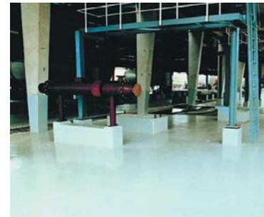
Für die dauerhafte Sicherheit von besonders stark beanspruchten Flächen in einem Chemiewerk wurden bei der großflöchigen Sanierung Vinylesterbeschichtungen eingesetzt.
