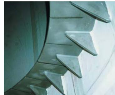
Konsolebene einer mehrschichtig ausgekleideten Brennkammer vor (oben) und während der Montage (unten), der Blechmantel ist versehen mit einem wärmefesten Korrosionsschutz.
