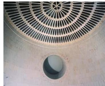
Gaseintrittsstützen und darüber ein freitragender Steuler-Kuppelrost aus säurefestem Keramikmaterial.
