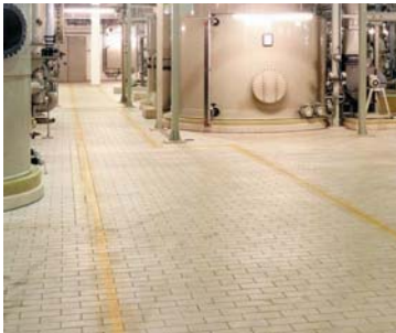
Industriefußböden mit ebenflächig aufgebauten Fahrbereichen und zusätzlicher Plattierung in der Wasseraufbereitungsanlage.
