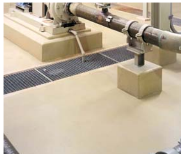
Rissüberbrückende Fußbodenbeschichtung in einem Absorbergebäude, GfK-Rohrleitungen, Rinnensysteme und Gitterroste.
