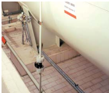
Abdichtung mit bauaufsichtlicher Zulassung einer Auffangwanne in einem Säurelager mit zusätzlicher Plattierung.
