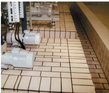
Ausbildung der Pumpenfundamente sowie der Wannenflächen.
