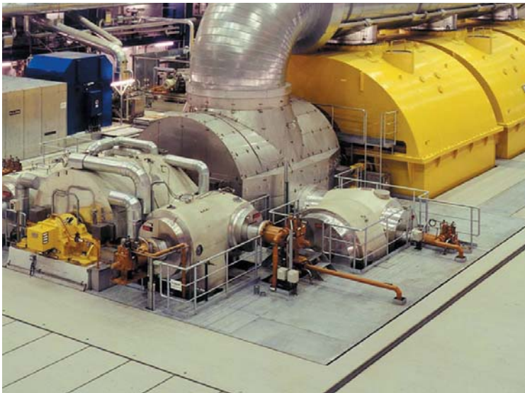
Gesamtansicht der Turbinendecke mit keramischer Plattierung im Rüttelverfahren verlegt.
