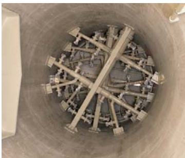
Betonkonstruktion eines Rauchgasentschwefelungswäschers mit mechanisch verankerter Thermoplastauskleidung.
