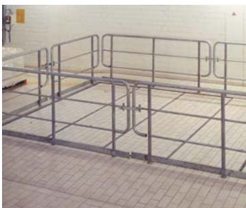
Montageöffnung mit entsprechender Anstrüfung im Bereich Kalksteinentladung.
