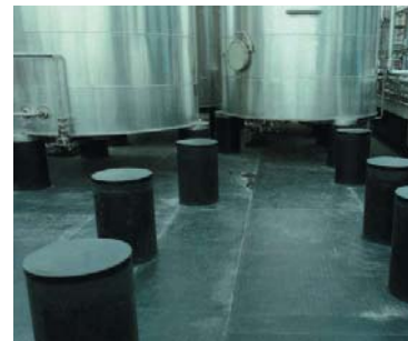
Auffangwannen mit mechanisch verankerter Thermoplastauskleidung mit bauaufsichtlicher Zulassung (DIBt-Prüfzeichen).
