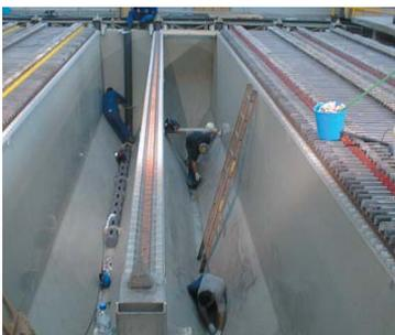
Zwei T-Elemente werden verschweißt und bilden eine Elektrolysezelle.
