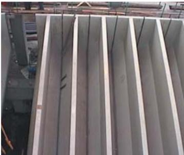
Die Elemente werden auf Zellbänke montiert.
