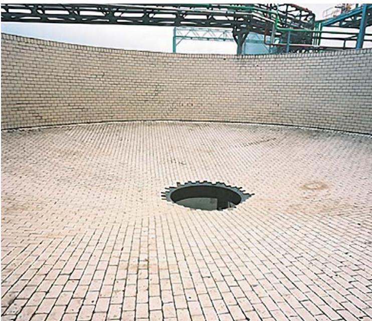
Gummierter Eindicker aus Stahl mit säurefester Ausmauerung.
