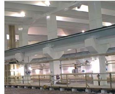
Die gesamte Hallenkonstruktion wurde mit einer spritzfähigen Beschichtung gegen aggressive Dämpfe geschützt.
