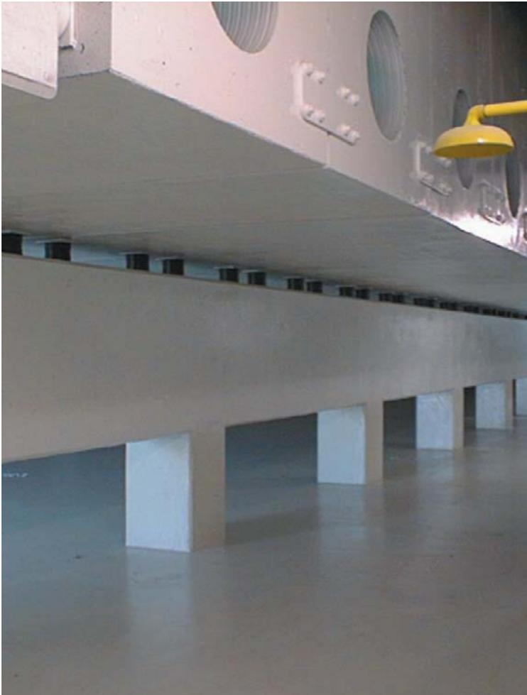
Unterhalb der Elektrolysezellen schützt eine Polyurethanbeschichtung sicher auch gegen die aggressive Elektrolytlösung.
