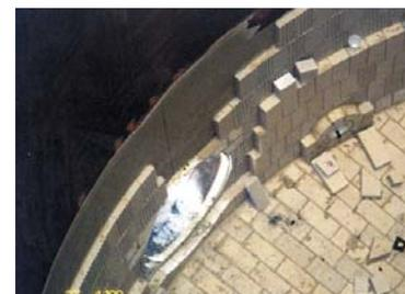
Dreilagige Ausmauerung eines Absorptionsturms mit säurefester Keramik.
