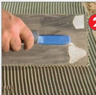
**2** Оба компонента **AQUAFIN®-DIC** смешать до однородного состояния и в зависимости от степени нагрузки нанести в один или два слоя. Для достижения равномерной толщины слоя **AQUAFIN®-DIC** прочесать с помощью соответствующей для требуемой толщины слоя зубчатого шпателя и затем равномерно разгладить.
