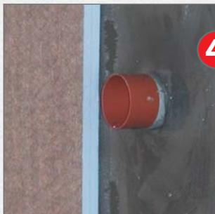
**4** В области водяного давления, если гидроизоляция должна быть выполнена в соответствии с DIN 18195\*\*, **AQUAFIN®-DIC\*** наносить в два слоя; между слоями установить усиливающую прокладку.
