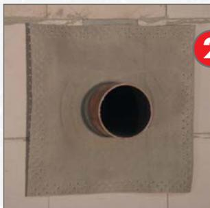
**2** Поверх трубы вне зоны действия воды под давлением установить соответствующую манжету и полностью проклеить **AQUAFIN®-2K/M**. В области действия воды под давлением требуется применять прижимные муфты.
