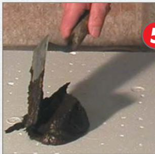
**5** INA-Schutz- und Drainelement наклеивается при помощи материала **COMBIDIC®** на сухой гидроизоляционный слой. При этом клей может наноситься на обратную сторону плиты комком и прочесывается по всей поверхности.
