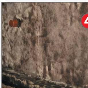
**4** В области с нагрузкой воды под давлением, если гидроизоляция должна быть изготовлена согласно DIN 18195, вмонтировать усиливающую прокладку между слоями. Для надежной защиты гидроизоляционного слоя на свежее КМВ укладывается **ASO®-Systemvlies-02** и равномерно прижимается гладилкой.
