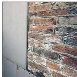
Плиты наклеиваются на подготовленное основание с помощью **THERMOPAL®-GP11** и могут уже на следующий день шпаклеваться с помощью **THERMOPAL®-FS33** и окрашиваться **ADICOR®-SK**. При желании стыки между плитами можно оставить необработанными.
