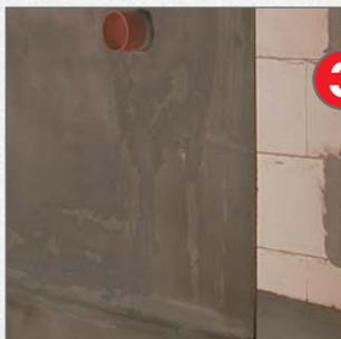
**3** В случае неблагоприятных условий на каменной кладке могут образоваться пузырьки. Этому можно противодействовать нанесением **ASO®-Systemvlies-02** на свежее покрытие.
