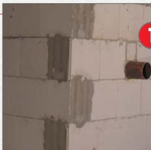
**1** Основания должны быть ровными, чистыми, обладать несущими способностями. Каменная кладка должна быть с заполненными швами. Наплывы удалить, выступающие каменные части выровнять. Поверх трубы вне зоны действия давления воды установить соответствующую **ADF®-Rohrmanschette** (манжета) приклеить по всей поверхности с помощью **AQUAFIN®-DIC\***. В области давления воды\*\* требуются прижимные муфты (например, Doyma).
