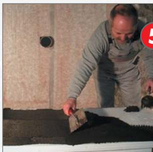
**5** **INA-Schutz-** и **Drainelement** наклеить с помощью **COMBIDIC®** на сухой гидроизоляционный слой. При этом клей может наноситься комками на обратную сторону плиты и прочесываться по всей поверхности.
