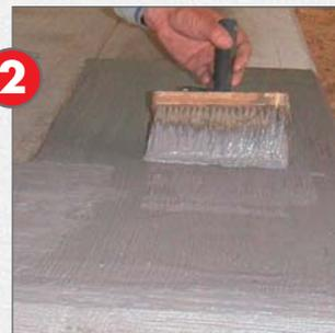
**3** Выступающую часть основания и его переднюю сторону включить в гидроизоляцию.
