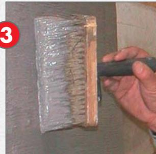
INA-Schutz- und Drainelement наклеивается при помощи материала COMBIDIC® на сухой гидроизоляционный слой. При этом клей может наноситься на обратную сторону плиты комком и прочесываться по всей поверхности.
