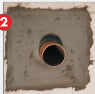
Оба компонента AQUAFIN®-2K перемешать до однородного состояния и в зависимости от степени нагрузки нанести в два или более слоев. Первый слой всегда наносить кистью, последующие слои на выбор наносятся кистью или шпателем.
