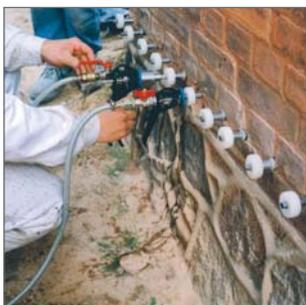
Жидкий гидроизоляционный материал запрессовывается под давлением примерно 10 бар в по меньшей мере один горизонтальный шов. В просверленных отверстиях диаметром 18 мм применяются пакеры с самозакрывающимся обратным клапаном. **AQUAFIN®-F**, **AQUAFIN®-SMK** или **AQUAFIN®-IB2** запрессовываются затем при помощи инжектора.
