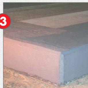
**4** В углу места присоединения стена / основание наклеить гидроизоляционную ленту\*\* (Dichtband) при помощи AQUAFIN®-2K/M или изготовить из цементного раствора скругленную галтель и обработать материалом. Таким образом, нанесенное на слой AQUAFIN®-2K/M KMB (толстослойное битумно-полимерное покрытие) защищается от отрицательного давления на отрыв.
