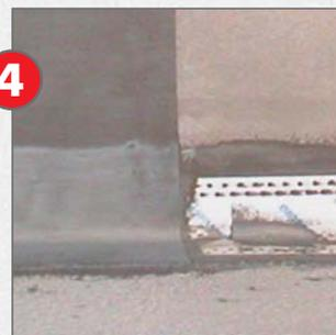
**5** Для наклеивания гидроизоляционной ленты (Dichtband) AQUAFIN®-2K/M перемешать только с половиной дисперсии. Требуемая консистенция, готовая к нанесению шпателем, устанавливается добавлением воды. AQUAFIN®-2K/M наносить шпателем с высотой зубца 4 мм, гидроизоляционную ленту прижать и зашпаклевать.
