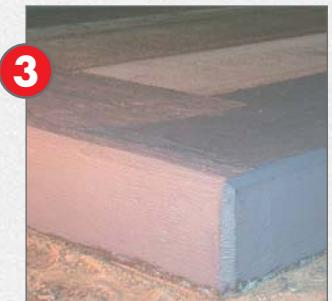
В углу места присоединения стена / основание наклеить гидроизоляционную ленту\*\* (Dichtband) при помощи AQUAFIN®-2K/M или изготовить из цементного раствора скругленную галтель и обработать материалом. Таким образом, нанесенное на слой AQUAFIN®-2K/M KMB [толстослойное битумно-полимерное покрытие] защищается от отрицательного давления на отрыв.
