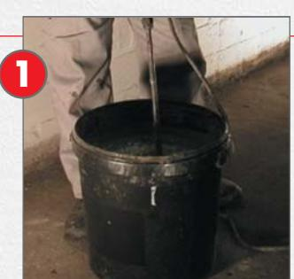
Гидроизолировать места примыканий от поднимающейся влаги с расходом минимум 3,5 кг/м<sup>2</sup> AQUAFIN®-2K/M. При этом наносить AQUAFIN®-2K/M минимум в два слоя. Используемые инструменты - плоская щетка или кисть.
