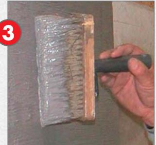
INA-Schutz- und Drainelement наклеивается при помощи материала COMBIDIC® на сухой гидроизоляционный слой. При этом клей может наноситься на обратную сторону плиты комком и прочекаться по всей поверхности.
