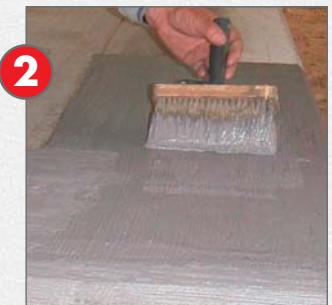
Выступающую часть основания и его переднюю сторону включить в гидроизоляцию.
