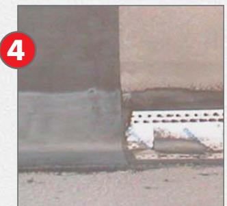
Для наклеивания гидроизоляционной ленты (Dichtband) AQUAFIN®-2K/M перемешать только с половиной дисперсии. Требуемая консистенция, готовая к нанесению шпателем, устанавливается добавлением воды. AQUAFIN®-2K/M наносить шпателем с высотой зубца 4 мм, гидроизоляционную ленту прижать и зашпаклевать.
