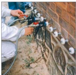
Жидкий гидроизоляционный материал запрессовывается под давлением примерно 10 бар в по меньшей мере один горизонтальный шов. В просверленных отверстиях диаметром 18 мм применяются пакеры с самозакрывающимся обратным клапаном.
