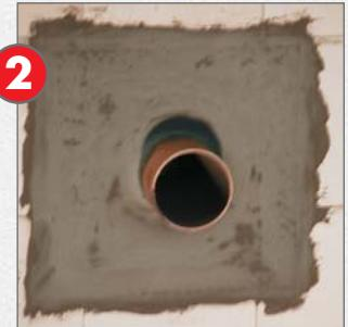
Оба компонента AQUAFIN®-2K перемешать до однородного состояния и в зависимости от степени нагрузки нанести в два или более слоев. Первый слой всегда наносить кистью, последующие слои на выбор наносятся кистью или шпателем.
