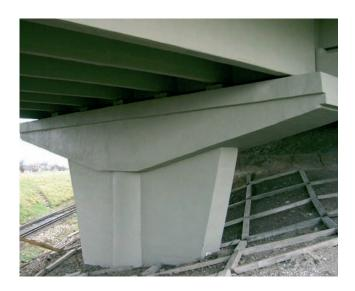
Специальные виды ремонтных растворов INDUCRET-BIS-5/40 и INDUCRET-BIS-1/6 могут в равной мере использоваться как методом 3.2 (нанесение раствора вручную), так и SPCC – метод 3.3 (нанесение бетона и раствора путем напыления).
