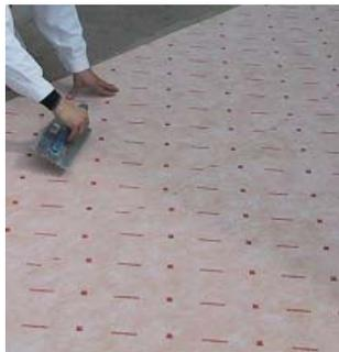
Входящий в систему гидрофобный тонкослойный клеевой раствор **ADF-Systemkleber** используется как на внутренних, так и на наружных поверхностях. Может применяться для крепления как ADF-Balkonfolie, так и плиточного покрытия. Наносится с помощью зубчатого шпателя с высотой зубца 4 – 6 мм, затем мембрана равномерно, без образования складок вдавливается в свежий клеевой раствор.
