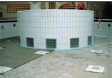
**AQUAFIN-POOL** — неоднократно использованная при строительстве бассейнов гидроизоляционная система, основными компонентами которой являются зарекомендовавшие себя на практике **AQUAFIN-2K/M** для пресной и морской воды и **ASOFLEX-AKB** для соленой или термальной воды.
