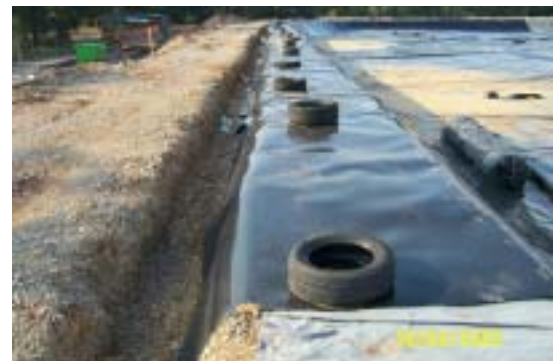
Anchor trench (Laibach)
