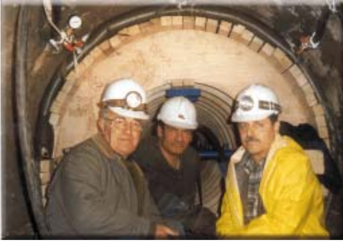
Abdichten der Abschlusssektion der Schalung sealing the termination section of the formwork
