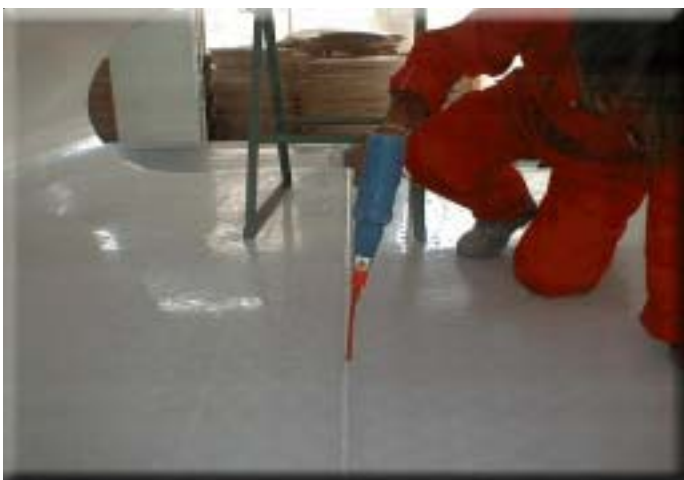
Funkentest an der Schweissnaht spark testing of welding seam
