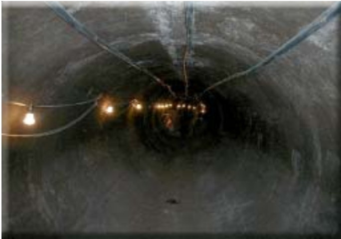
Installation der Injektionschlaeuche installation of grouting hose
