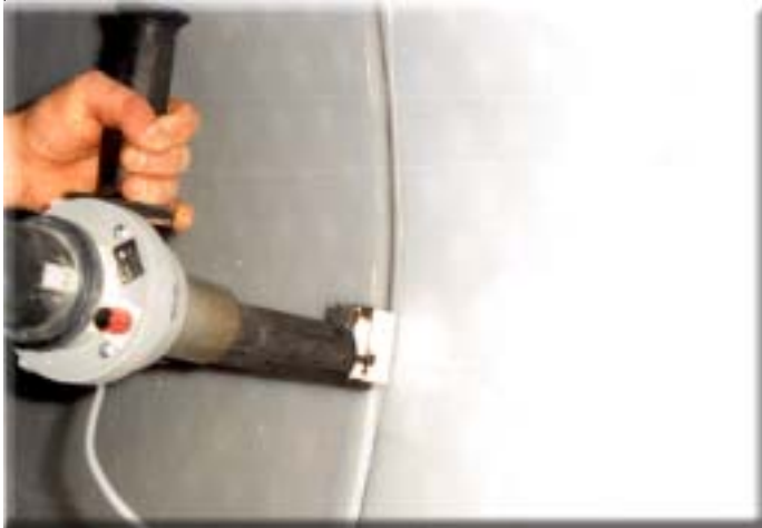
Extrusionsschweissung der einzelnen Segmente nach dem eingiessen des Moertels
