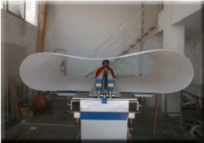
Schweissen des Inliners welding of Inliners
