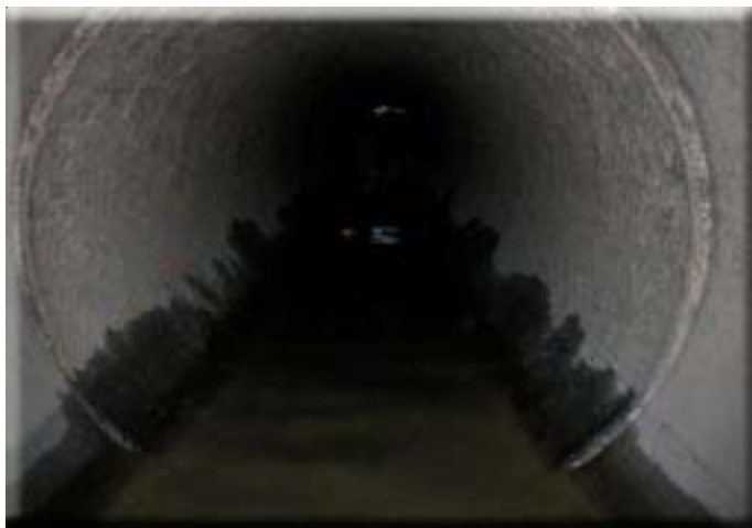
Ansicht des bestehenden Rohres view to existing pipe
