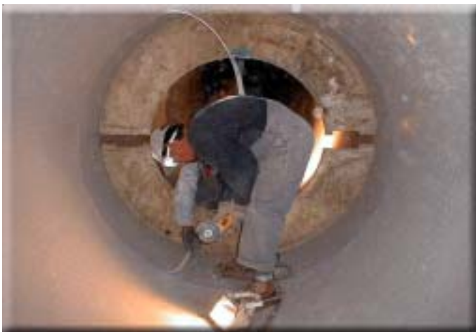
Abtrennen des Inliners in der Kruemmung Trimming of liner at bend section
