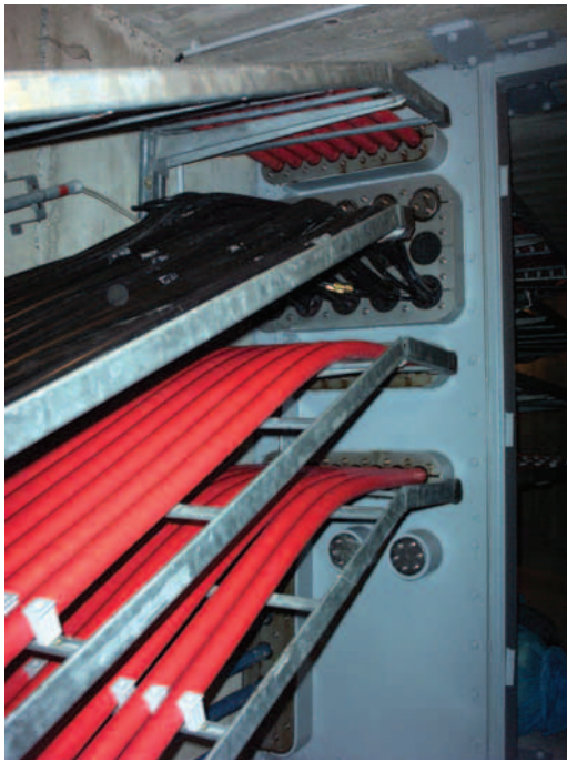
Kraftwerke benötigen Power: UGA Gummi-Press-Dichtungen GPD als Sonderkonstruktions-Rahmen zum Hochwasserschutz
