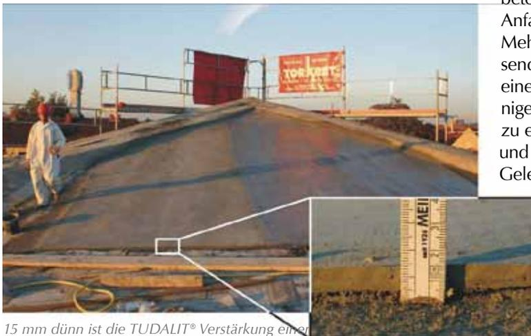
15 mm dünn ist die TUDALIT® Verstärkung einer Hyparschalenkonstruktion mit drei Lagen Carbondtextil in Schweinfurt.
