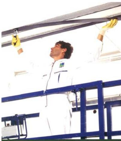
Монтаж ламелей на балочную конструкцию
