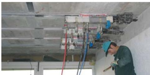
Усиление плиты перекрытия преднапряженными ламелями
